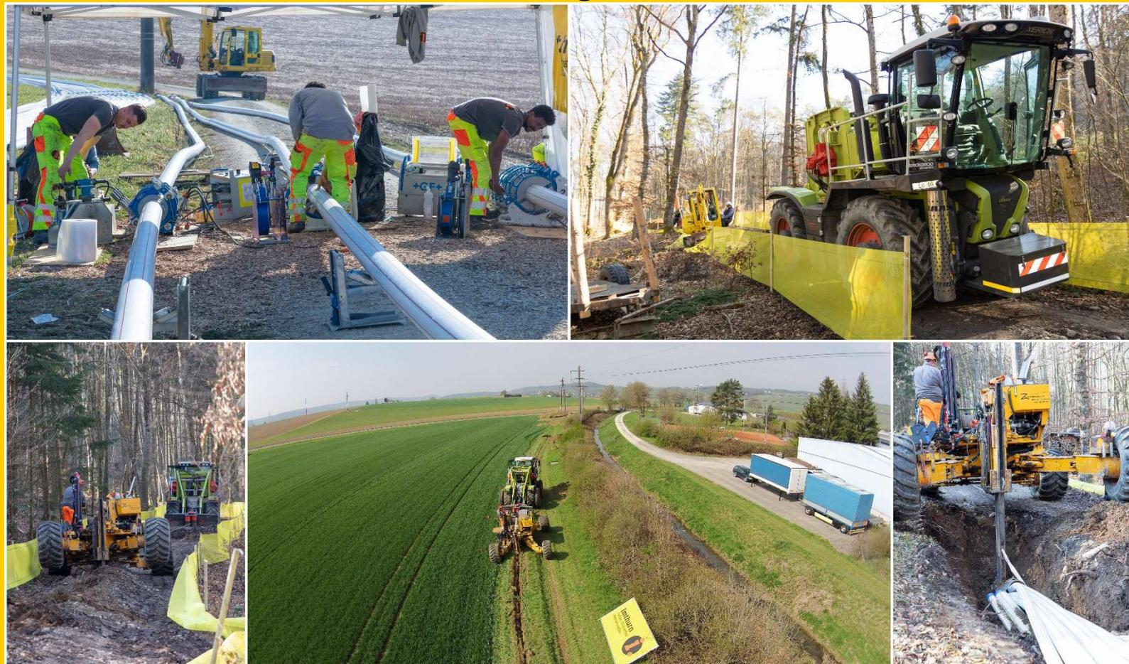
Dieses Projekt war ein besonderes Ausnahmeprojekt mit hoher Priorität und Beachtung seitens der Axpo Grid AG. Es wurde eine 110-kV-Kabelrohrblockanlage im Kabelpflugverfahren vom UW Wilchingen bis zum Anschluss an den bestehenden Kabelrohrblock erstellt. Das heisst wir haben auf einer Länge vom 7.6km insgesamt gut 57km Leerrohre eingepflügt und verlegt. Das Einpflügen von Kabelschutzrohren bietet eine kosteneffiziente, schnelle und bodenschonende Alternative zum konventionellen Grabenbau.
